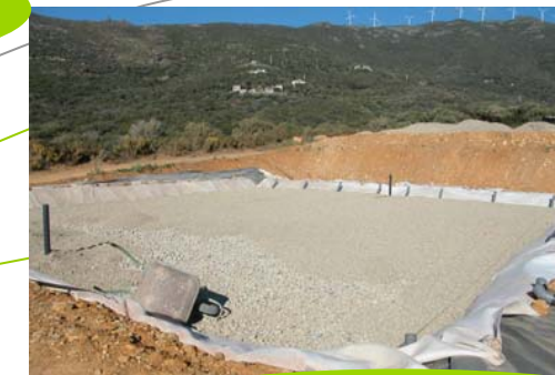
4/ Mise en œuvre des couches des différents matériaux de filtration
