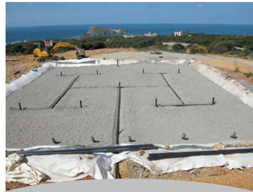
5/ Installation du réseau de répartition des effluents
