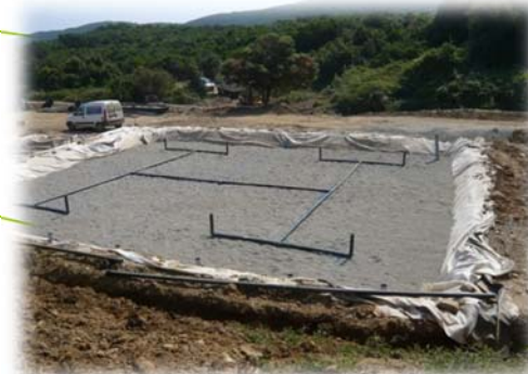
5/ Installation du réseau de répartition des effluents
