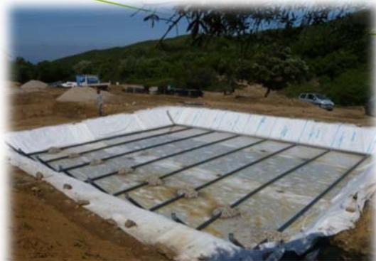
3/ Pose du réseau de drainage
