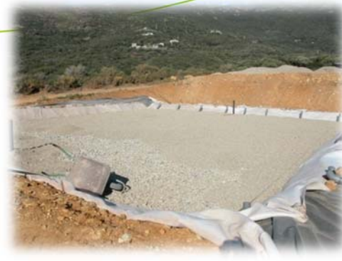
4/ Mise en œuvre des couches des différents matériaux de filtration
