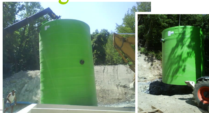
mise en œuvre du décanteur digesteur et du clarificateur
