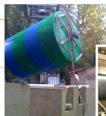
Essais et Mise en œuvre des réacteurs à disques biologiques
